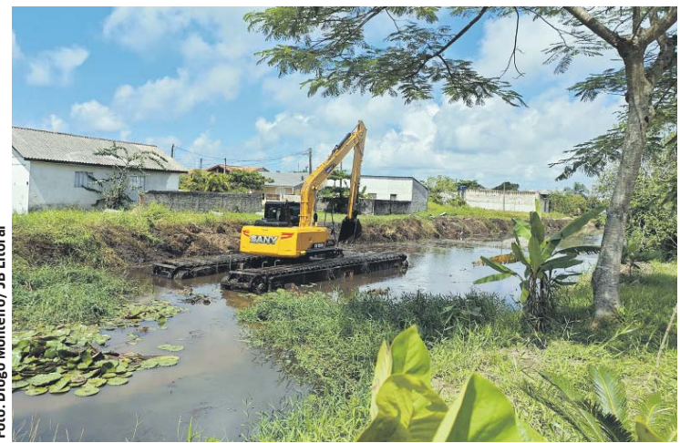
Máquina anfíbia atua no desassoreamento dos canais de Pontal do Paraná
